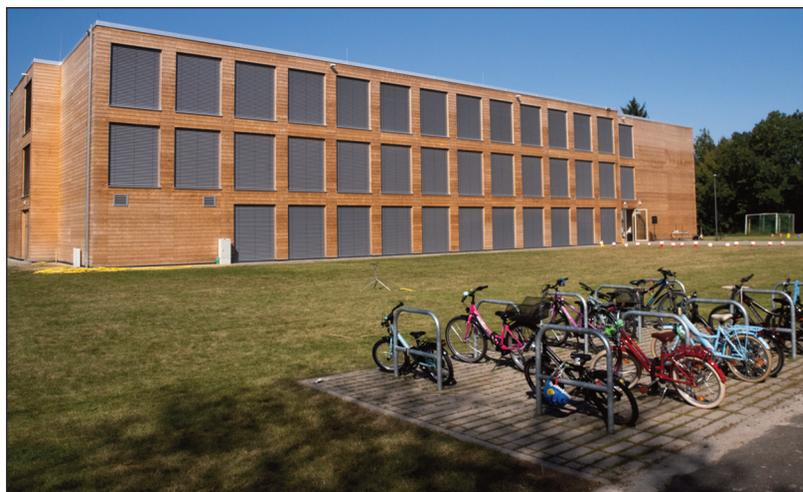
Der neue Ergänzungsbau entstand in modularer Holzbauweise.
