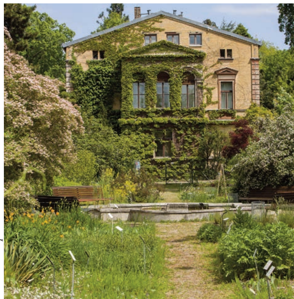
Späth-Herrenhaus, erbaut 1874. heute ein Teil des Instituts für Biologie der Humboldt-Universität zu Berlin. Foto: Daniela Incoronato
