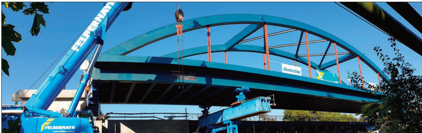
Die neue 900 Tonnen schwere Brücke wurde über den Teltowkanal platziert.
