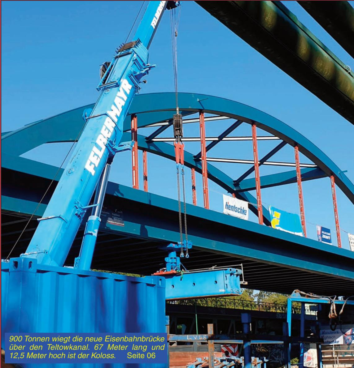
900 Tonnen wiegt die neue Eisenbahnbrücke über den Teltowkanal. 67 Meter lang und 12,5 Meter hoch ist der Koloss. Seite 06
