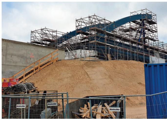
Beeindruckend: Widerlager für die Stabbogenbrücke über den Teltowkanal. Die vorbereitenden Arbeiten sind im Gange, man kann schon im Sommer mit dem Einbau der Brücke rechnen.
