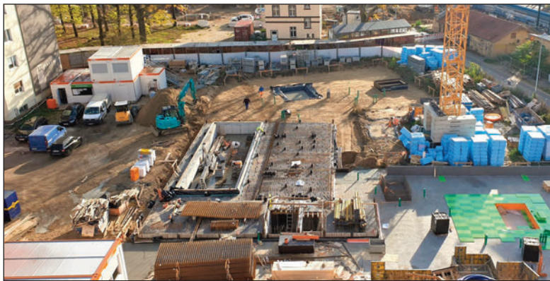
Neubau des Hauses zwischen Bahnhof und Hochhaus. Gut zu erkennen das zukünftige rechteckige Schwimmbad. Fotos: Heimann
