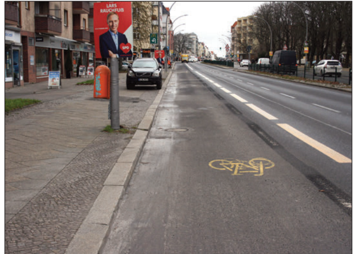
Am Mariendorfer Damm: Auch hier, kurz hinter der Richterstraße, wurden die alten Fahrbahnmarkierungen mit einer Wasserstrahlmaschine entfernt. Foto: Bothe
