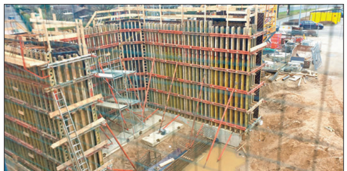
Bau der Brückenpfeiler für die Eisenbahnbrücke der Fernbahn am Schichauweg
