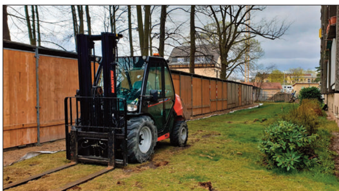
Anpassung der Zuwegung zum Behelfsbahnhof
