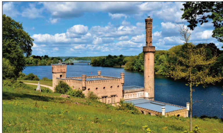
Das ehemalige Dampfmaschinenhaus für die Bewässerung des Parks und der Springbrunnen - im Hintergrund die Glienicker Brücke.
