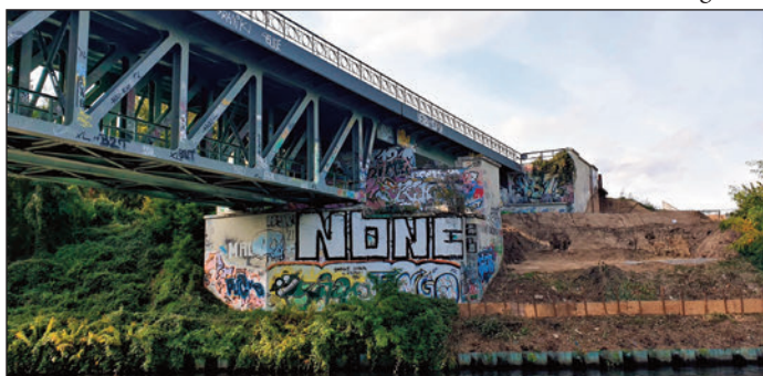
Vorbereitende Arbeiten für die Errichtung einer Stabbogenbrücke für die Fernbahn über den Teltowkanal.
