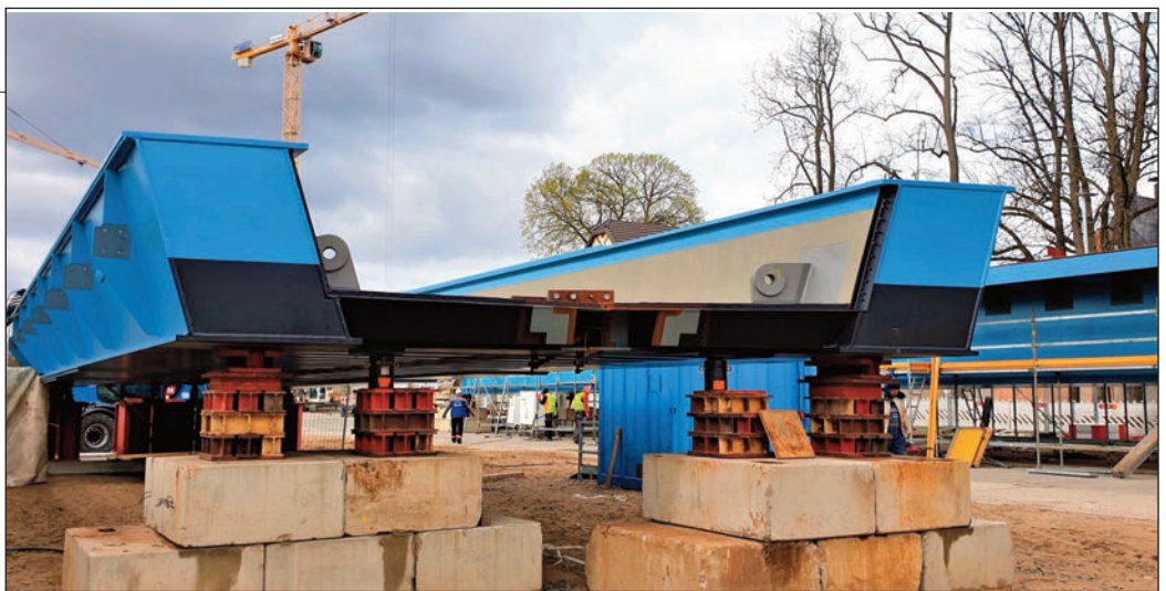
Auf dem Pfarrer-Lütgehaus-Platz erfolgt schrittweise der Zusammenbau des Straßentrogs über der Bahnhofstraße. Fotos: Heilmann
