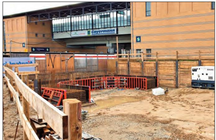
Vorbereitende Baumaßnahmen zum Bau der Widerlager rechts und links des S-Bahnhöfes Schichauweg.
