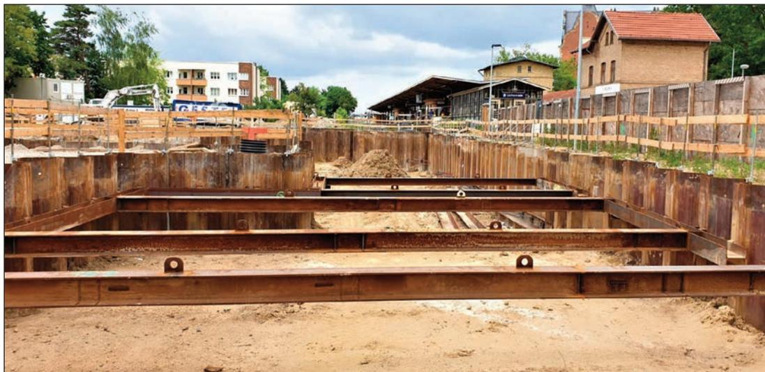
Die Arbeiten an den Spundwänden am S-Bahnhof Lichtenrade sind abgeschlossen, sodass mit dem Aushub bis zur endgültigen Tiefe begonnen werden kann.
