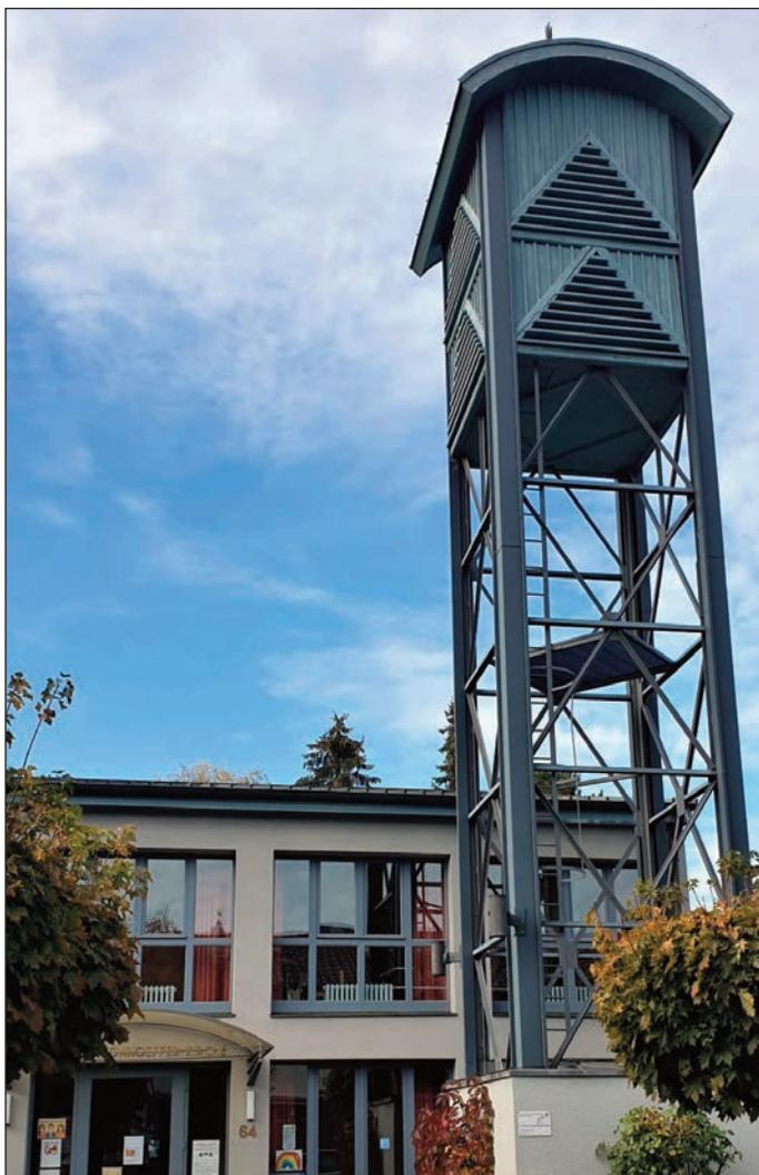
Der Glockenturm aus verkleideten Stahlfachwerk erbaut 1958, heutiges Aussehen nach Umbau 1975 mit neuer Hülle der Glockenhaube und freigelegten Turm.
